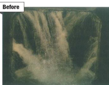
トンネル止水工事
